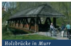
Holzbrücke in Murr
